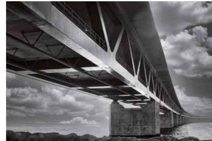
Brückenkonstruktion Elke Kritzer, Villingen-Schw.
