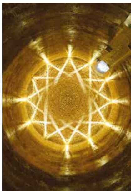
Die Windtürme der Wüstenstadt Yazd kühlen seit mehreren hundert Jahren die Temperaturen der Gebäude um bis zu 15° C. Das Wasser, auf das die eingefangene Luft fällt, wird durch unterirdische Kanäle - Qanate - aus dem Gebirge in die Stadt geleitet.
