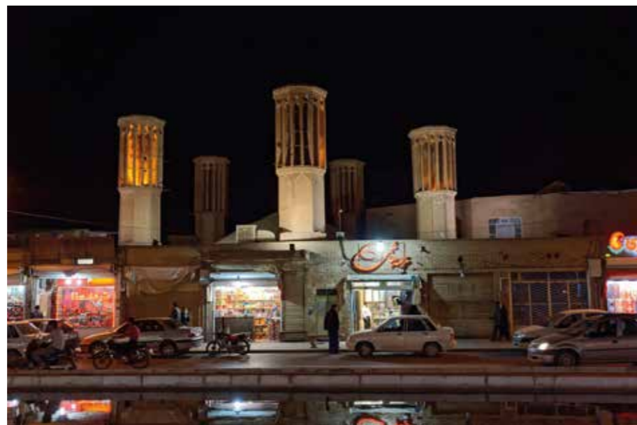
Die Windtürme der Wüstenstadt Yazd kühlen seit mehreren hundert Jahren die Temperaturen der Gebäude um bis zu 15° C. Das Wasser, auf das die eingefangene Luft fällt, wird durch unterirdische Kanäle - Qanate - aus dem Gebirge in die Stadt geleitet.
