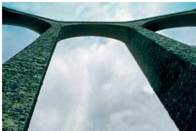
Landwasserviadukt Renate Zoch, Hamm
