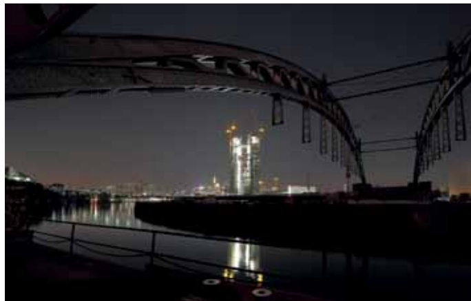
Brückenschlag Bernhard Hüsken, Frankfurt/Main
