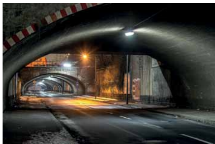
Eisenbahnbrücken Andreas van Beek, Köln
